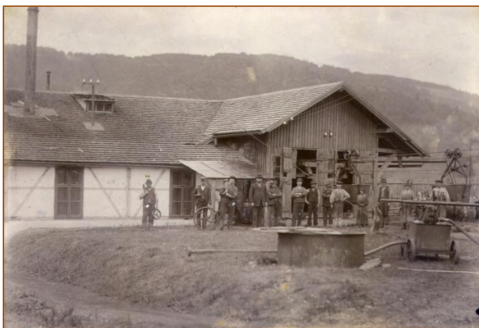
Rozdeľovacia stanica Krištof na Rovni, keď bola v prevádzke
