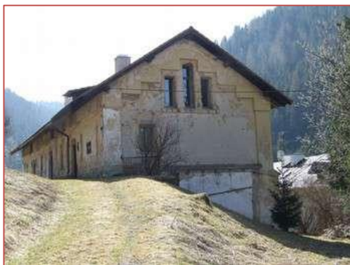
Bývalé byty pre úradníkov a technikov
