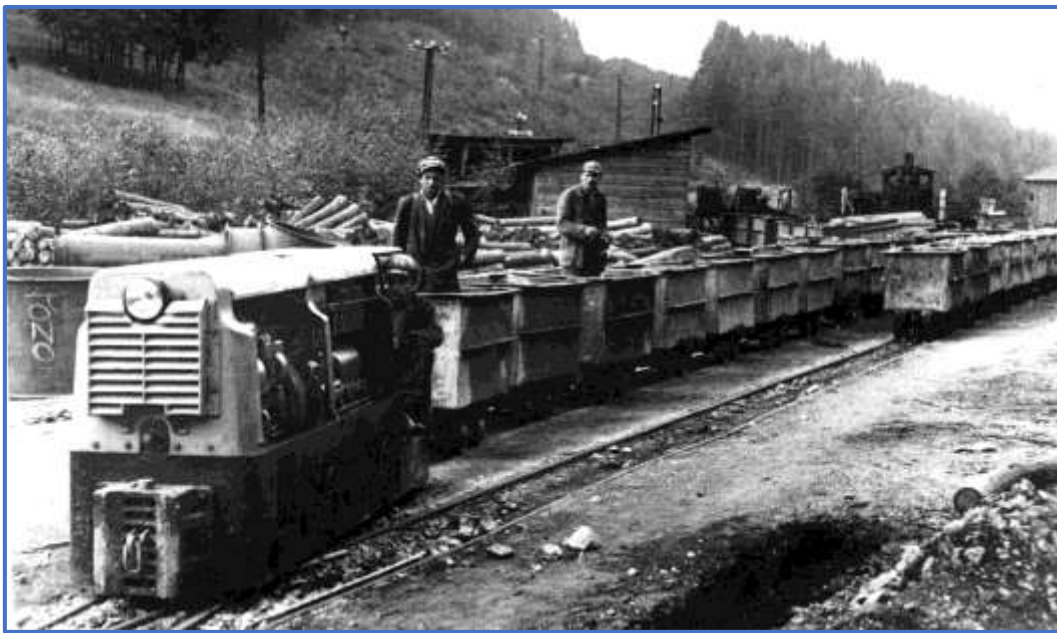
Obr. 82: Doprava dieselovou lokomotívou na Dedičnej štôlni Dobšiná v roku 1963
