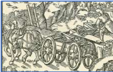
Obr. 19 a 20: Preprava surovín povozom a saniami ťahaným koňmi (podľa Agricolu 1556)
