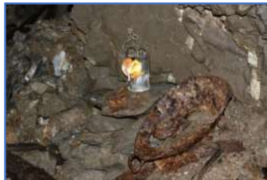
br. 7: Železný košiar tzv. brotvan, často používaný na nakladanie rudy (Szemán 2003) a jeho ostatok nájdený v štôlni Karol (archív O. Rozložník)
