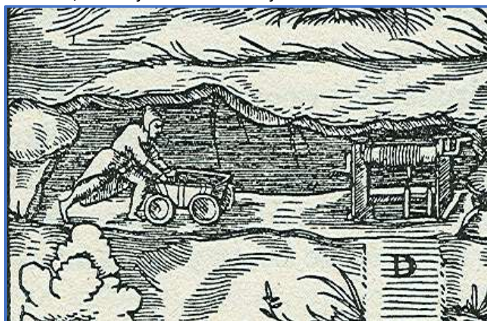
Obr. 35: Banský vozík s drevenými kolesami so železnými obručami podľa Agricollu z roku 1556
