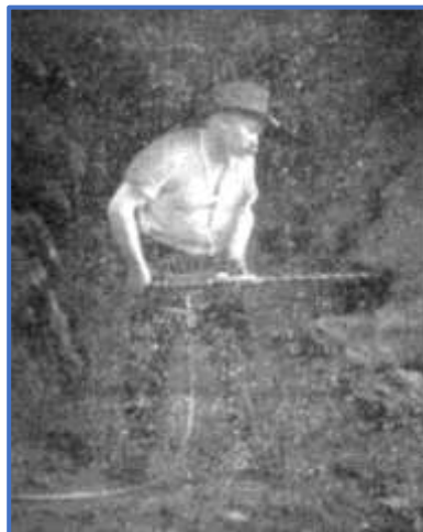
Vŕtacie práce v bani pomocou vrtačky Westfália (podľa Jó Szerencsét č. 34, 24. 5. 1908)
