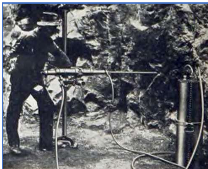
Vŕtacie kladivo typu Rex a jeho použitie v prevádzke
