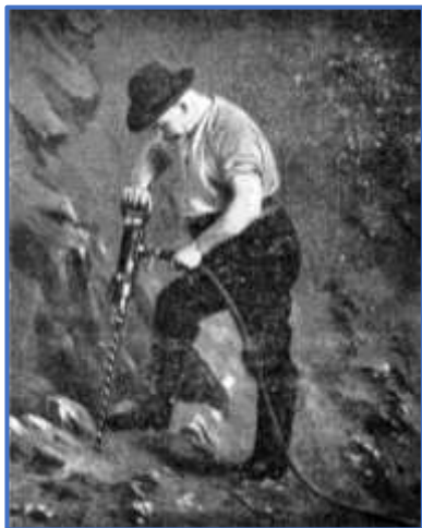
Vŕtacie práce v bani pomocou vrtačky Westfália (podľa Jó Szerencsét č. 34, 24. 5. 1908)
