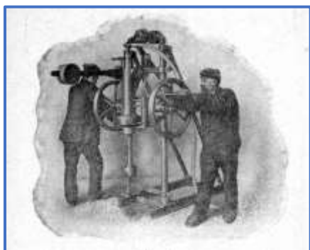
Vŕtacie zariadenia s diamantovým ostrím typu Senft – Urbanek
