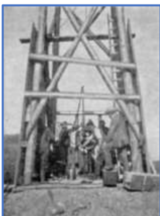
Vŕtacie zariadenia s diamantovým ostrím typu Senft – Urbanek
