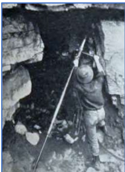
Vrtacie kladivá typu Ingersoll M V, Ingersoll Little Jump a Ingersoll s oporou vrtačky v prevádzke
