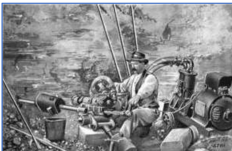
Elektropneumatická vrtáčka spoločnosti Ingersoll Rand z roku 1910 v prevádzke (Electric-Air Rock Drill)
