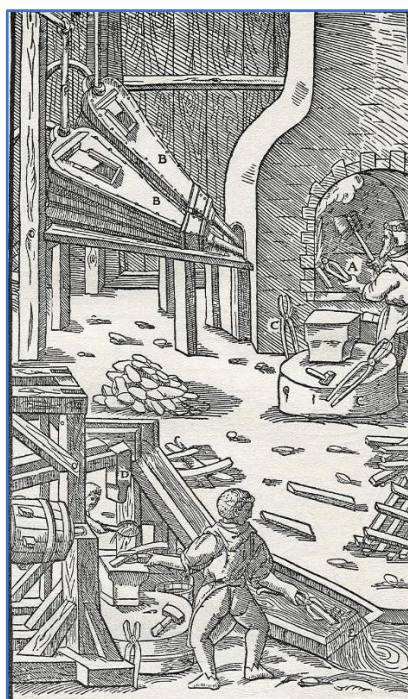
Nákres redukčnej vyhne a stredovekej hute podľa J. Agricolu z roku 1556
